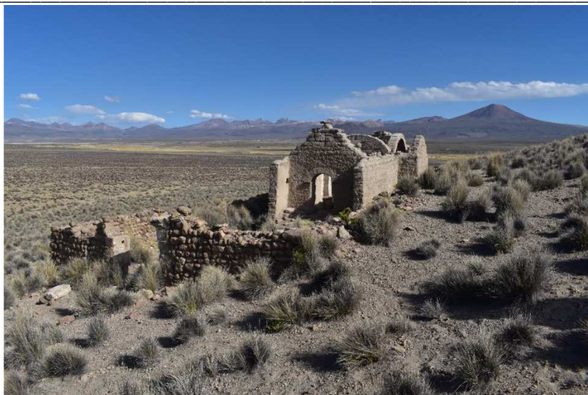
Figura 94. Capilla de Ancouyo, muestra la utilización de bloques de ignimbrita o sillar con bloques de adobe
