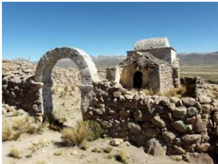
Figura 75. Muro perimétrico y arco de ingreso en la capilla de Tucibanasa
