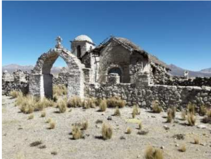
Figura 74. Muro y arco de ingreso a la capilla de Conchachiri.
